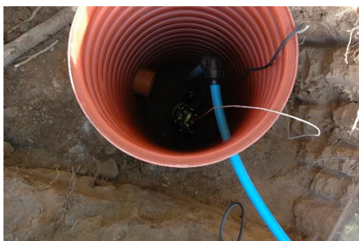
Figura 2. Estação de bombagem na escavação
