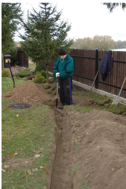
Figura 3. Escavação manual para tubagens
