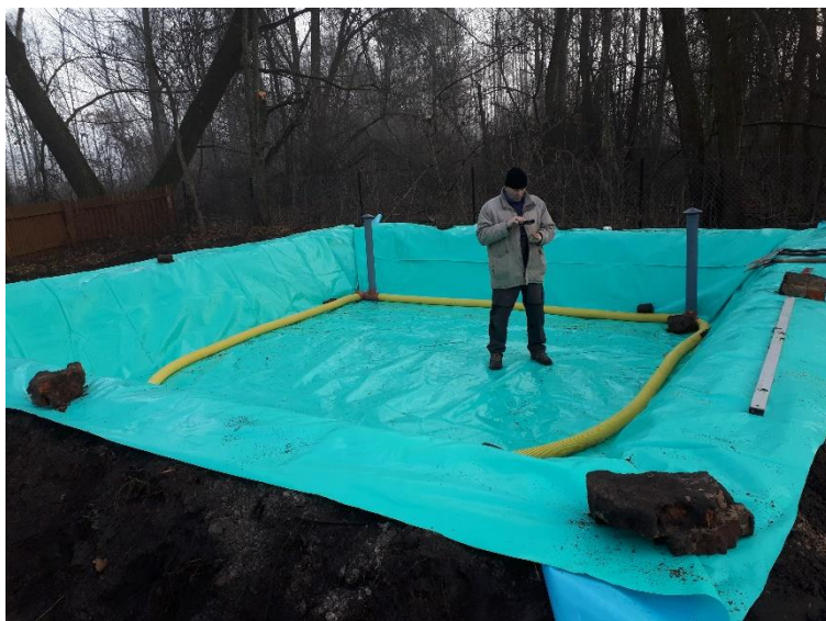
Figura 7. Colectora de drenagem
