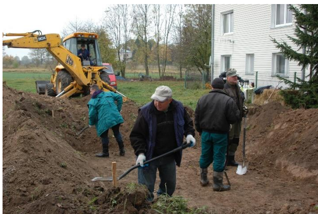
Figura 2. Escavação para o filtro de areia
