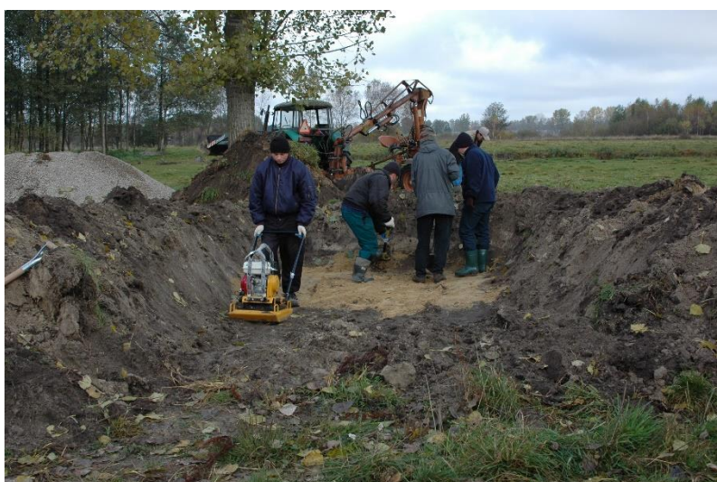
Figura 6. Perfilagem do fundo da escavação
