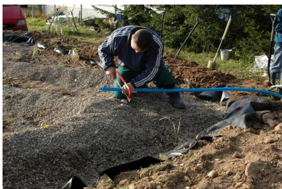
Figura 2. Ligação do tanque do colonizador à drenagem infiltrante
