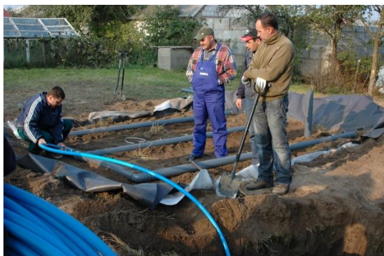
Figura 2. Ligação do tanque do colonizador à drenagem infiltrante
