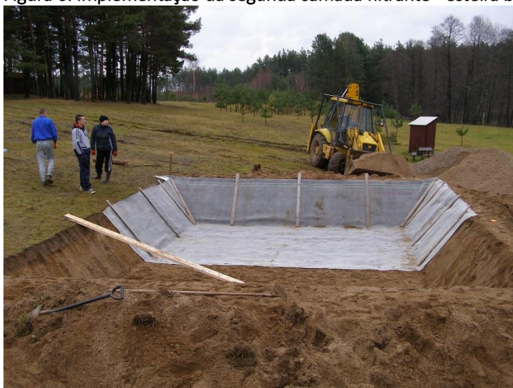
Figura 6. Implementação da segunda camada filtrante - esteira bentonítica
