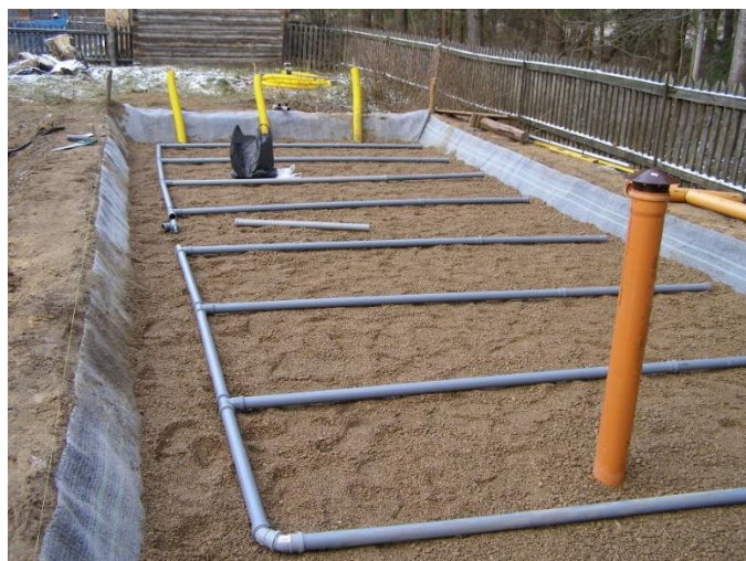
Figura 11. Instalação do esgoto infiltrante
