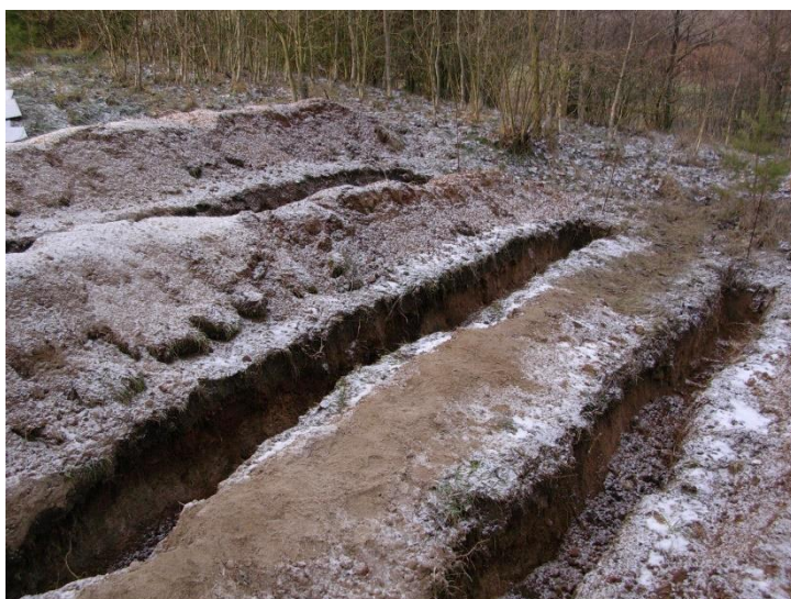
Figura 4. Escavação mecânica para drenagem
