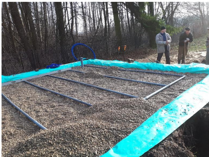
Figura 12. Drenagem infiltrante no aterro
