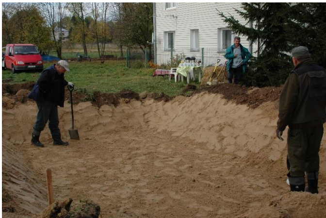
Figura 4. Realização da primeira camada do filtro - areia para o filme.
