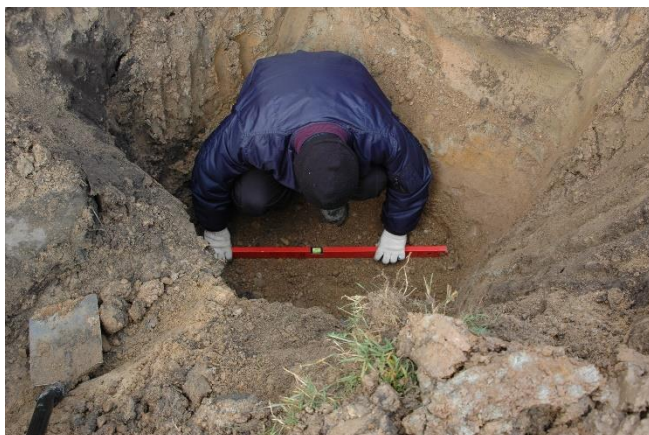
Figura 5. Nivelamento do fundo da escavação
