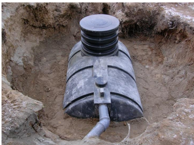
Figura 1. Montagem da fossa séptica
